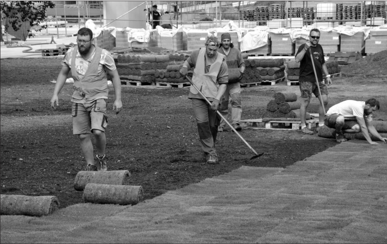
Na začátku týdne došlo k ozelenění první velké plochy v centru. V prostoru mezi hlavním koridorem v centru a ulicí Štefánikovou byly položeny travní koberce, které mají zajistit rychlejší uchycení zátěžového trávníku.
