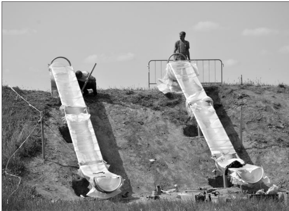
Skluzavky už byly nainstalovány na místo, nyní Slumeko musí dokončit dopadové plochy a terénní úpravy. Poprvé by se děti měly sklouznout začátkem července.
