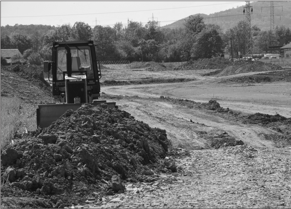
V lokalitě na Holotě v Lubině probíhá výstavba hrázky a odvodňovacího příkopu, které mají zabránit zaplavování zahrad a sklepů nedalekých domů.
