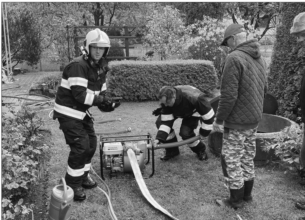
Dobrovolní hasiči ve Vlčovicích při odčerpávání vody z nevyužité studny, která se zaplnila při vytrvalých deštích a tlačila spodní vodu do sklepa rodinného domu.
