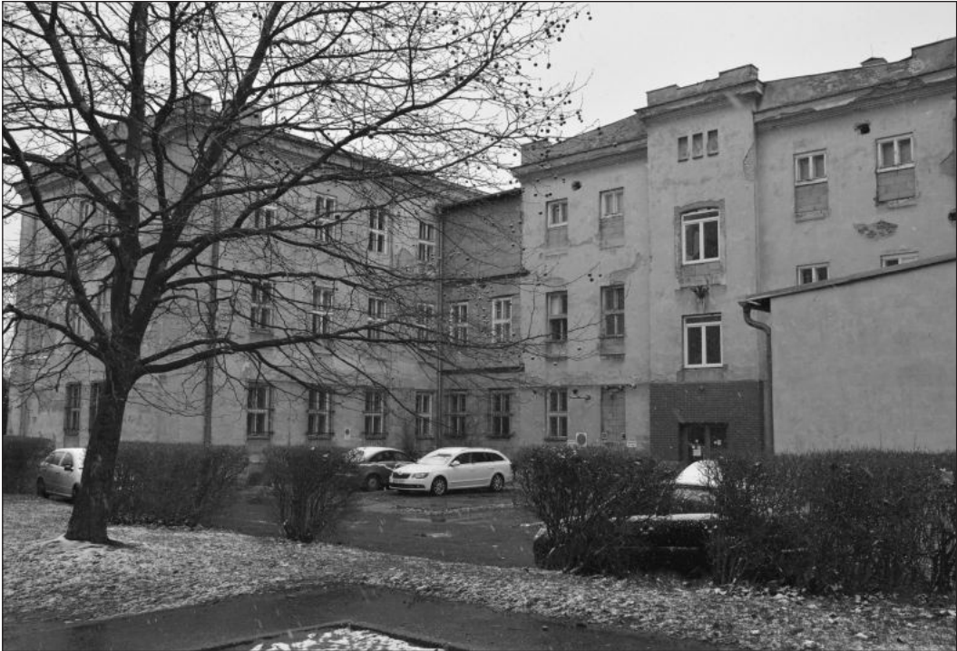
Aktuální majitelé objektu Kasáren v Kopřivnici chtějí nevzhledný a chátrající objekt nejméně čtvrtmiliardovou investicí proměnit na atraktivní bydlení.
