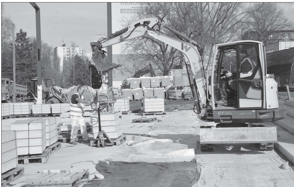
Práce na revitalizaci centra pokračují nejen pokládkou dlažby. V nejbližších týdnech budou probíhat také sadové úpravy a výsadba zeleně. Centrální část stavby by měla být dokončena do konce června.
