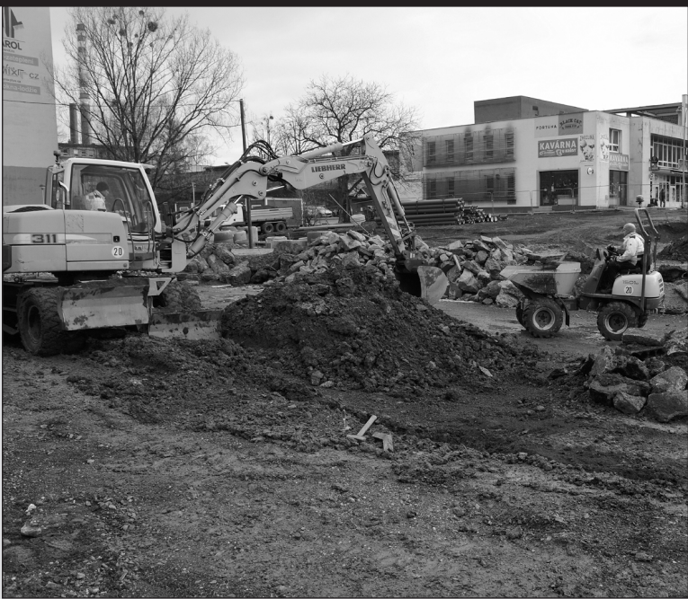
V minulém týdnu začaly práce na odvodnění v prostoru před kulturním domem, v tomto týdnu budou pokračovat v horní části centra města a částečně omezí pohyb chodců.
