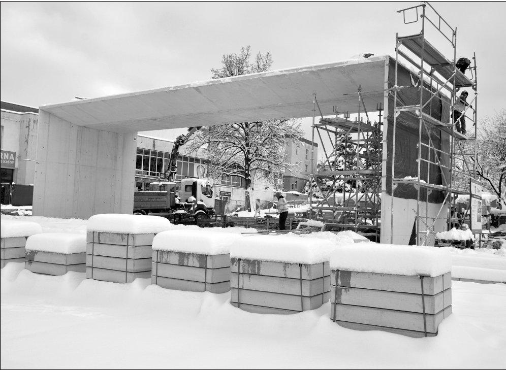
V úterý 13. prosince proběhla demontáž bednění a lešení budoucí Lašské brány. Hlavní práce na dominantě centra města tak byly ukončeny. Aktuálně práce na revitalizaci centra Kopřivnice stojí kvůli klimatickým podmínkám.
