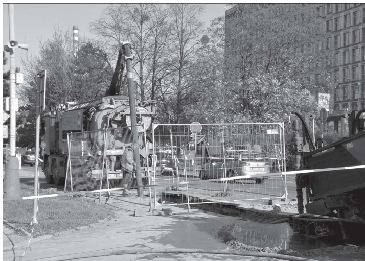
Stavební práce na výměně vodovodního řádu na ulici Štefaníkově, jejichž investorem je SmVaK, by měly skončit v závěru tohoto měsíce. FOTO: KATEŘINA HOLUBOVÁ
