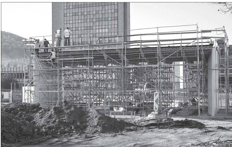
Tento týden došlo na betonování stropní desky Lašské brány, která má být hlavním ozvláštňujícím prvkem nové rekonstruovaného centra Kopřivnice. FOTO: DAVID MACHÁČEK
