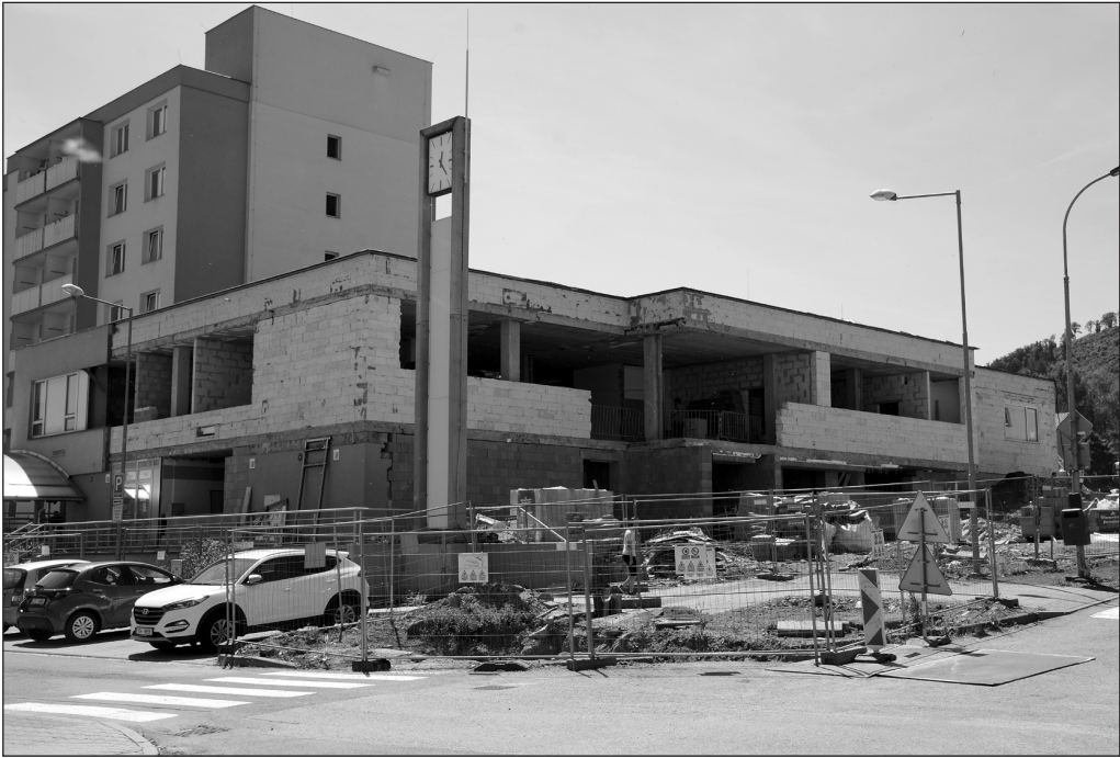
Stavba domova pro seniory na ulici Příčné pokračuje. Kraj jako investor a stavební firma vyjednávají o způsobu založení novostavby. Zatím probíhají úpravy někdejší stravovny. FOTO: D. MACHÁČEK
