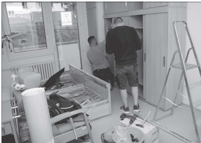
Ještě na začátku tohoto týdne probíhaly v rekonstruovaných domovinkách dokončovací práce a instalace nábytku. Nyní jsou už opět v provozu. FOTO: DAVID MACHÁČEK
