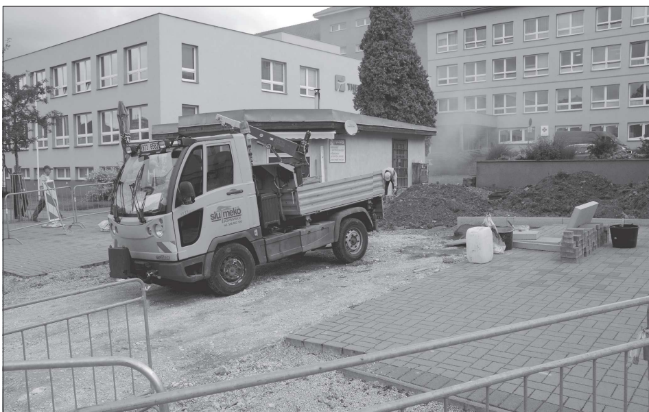
V rámci probíhající rekonstrukce před poliklinikou na ulici Štefánikově bude odstraněn sjezd na komunikaci. Na jeho místě vznikne vegetační plocha s trvalkovým záhonem, upravena bude i dlažba. Práce mají být dokončeny v příštím týdnu. FOTO: D. MACHÁČEK
