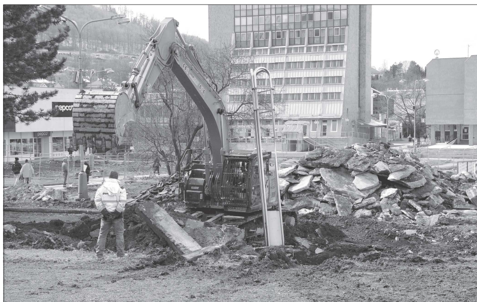
V centru města vrcholí fáze demoličních prací. Následovat by měla instalace inženýrských sítí a budování základů připravovaných staveb. Průchod staveništěm bude omezen pouze na úzký koridor.
