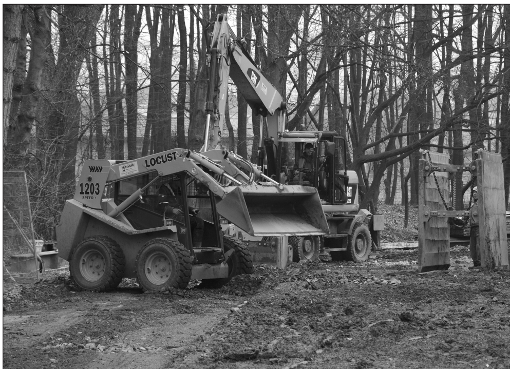
Zatímco v Mniši je výstavba kanalizačních stok v plném proudu, v sousedních Vlčovicích se pomalu připravují ke zkušebnímu provozu.
