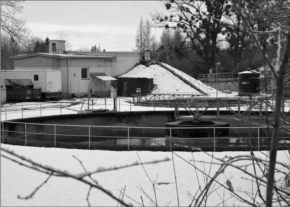
V letošním roce byla dokončena dosazovací nádrž, která má zvýšit kapacitu kopřivnické čističky odpadních vod před napojením dalších místních částí. ILUSTRAČNÍ FOTO: KN
