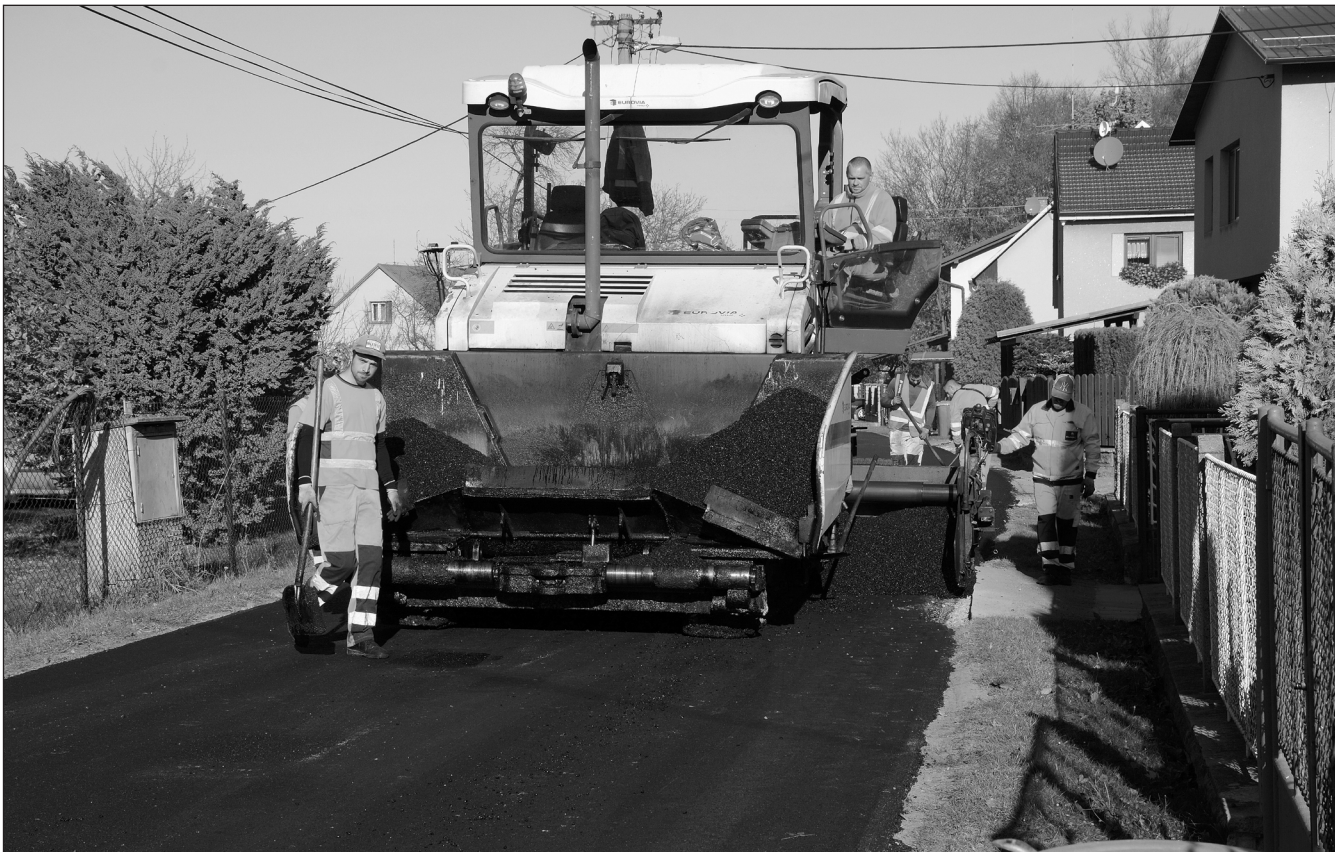
Práce na budování kanalizace ve Vlčovicích se chýlí ke konci. Rozkopané místní komunikace se v těchto dnech dočkaly nového povrchu.
