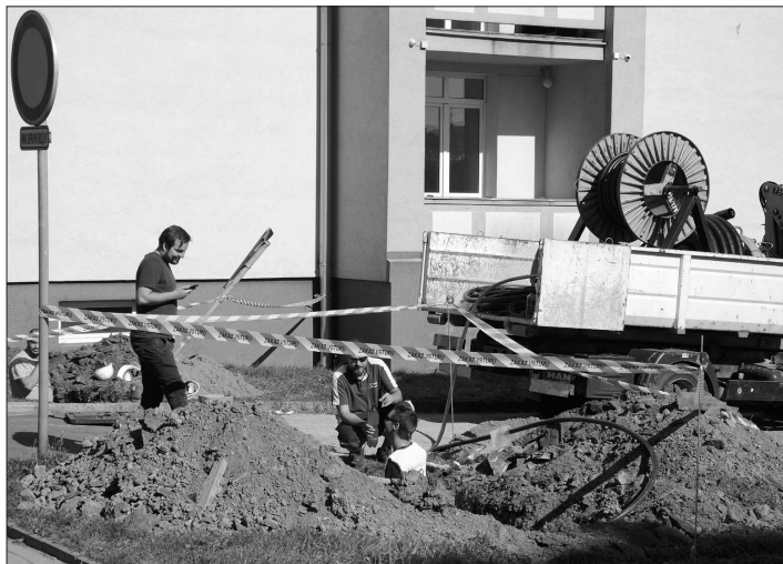
V okolí budoucího domova pro seniory už probíhají první přípravné práce. V minulém týdnu byly zahájeny přeložky rozvodů elektrické energie. FOTO: DAVID MACHÁČEK
