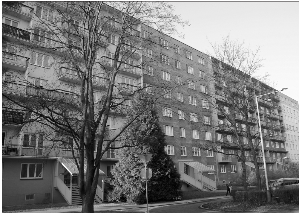
Plánovaná rekonstrukce by měla sjednotit fasádu bloku domů na ulici Dukelské. Vizualní podobu po opravách firma konzultovala s městskými architekty. FOTO: DAVID MACHÁČEK
