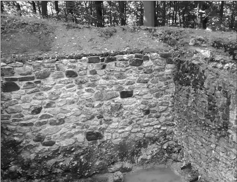
Oprava staticky narušených zbytků zdí hradního paláce Šostýna skončila v dvouměsíčním předstihu.
