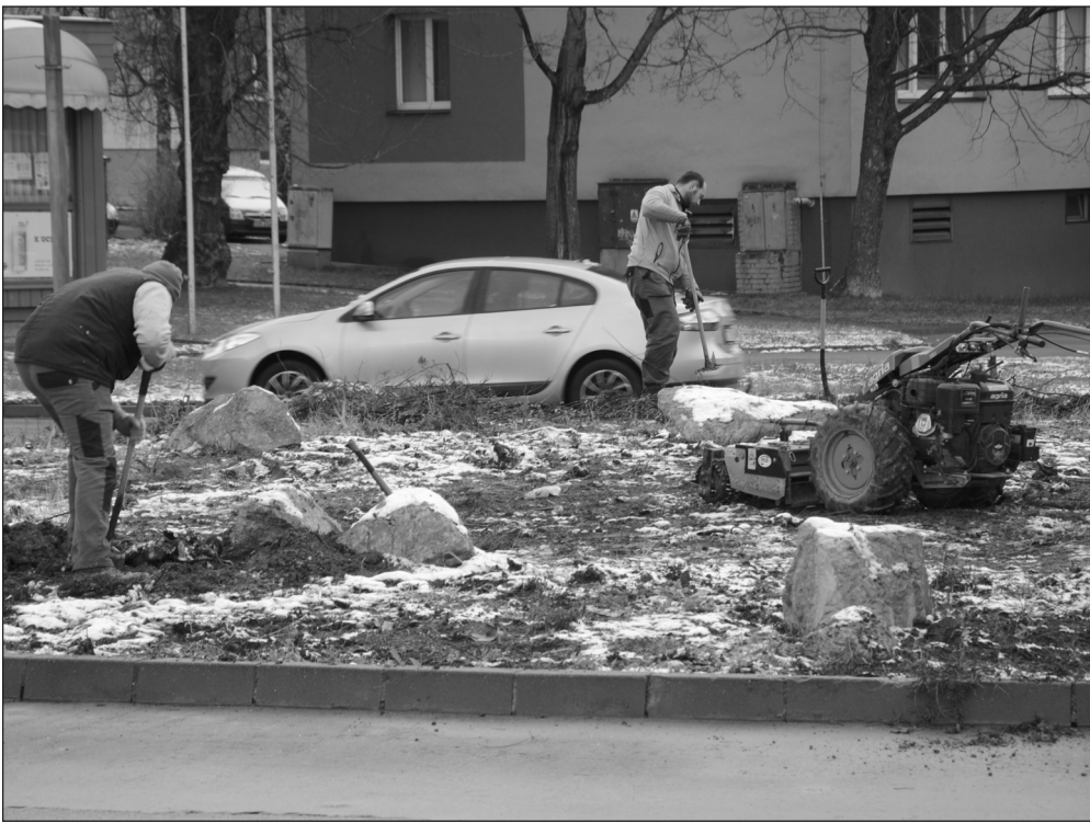
Úpravy okružní křižovatky ulic Záhumenní, Čs. armády a Obránců míru začaly v prosinci a dokončeny budou až na jaře. FOTO: DAVID MACHÁČEK
