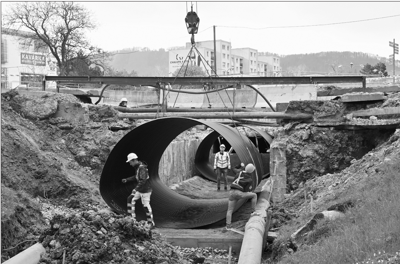
V rámci výměny zatrubnění Kopřivničky byly na místo usazeny první části tubosideru, kterým bude nejpозději letos na podzim potok protékat v úseku od hotelu Tatra po ZŠ Milady Horákové.
