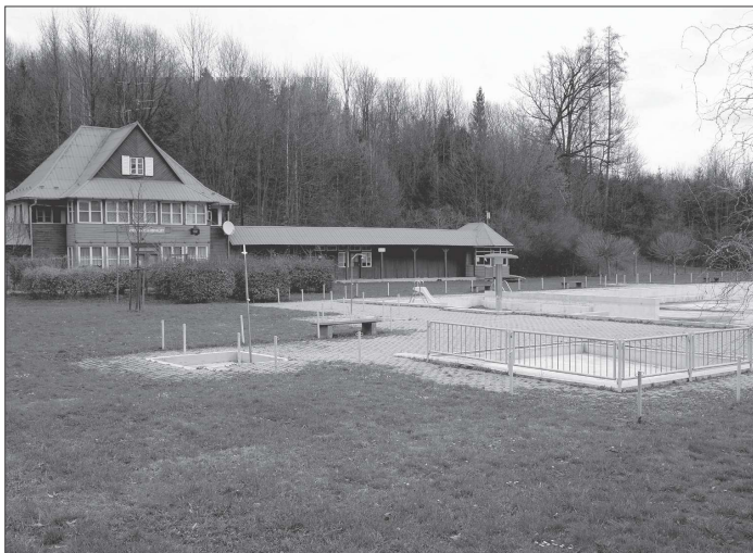
Areál populárního libotínského koupaliště je stále pustý. Letos v létě by ale místo koupajících měl patřit stavební firmě, která jej zrekonstruuje.
