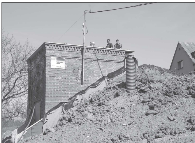
V okolí historického vodojemu, který prošel rozsáhlou rekonstrukcí, probíhají dokončovací terénní práce.
