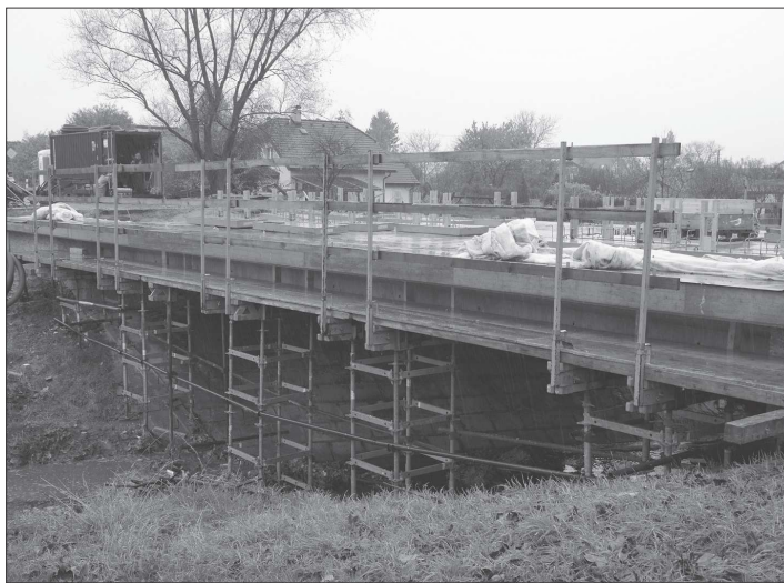
Jedním z realizovaných bodů Akčního plánu byla v loňském roce kompletní rekonstrukce silničního mostu na ulici Severní. FOTO: DAVID MACHÁČEK
