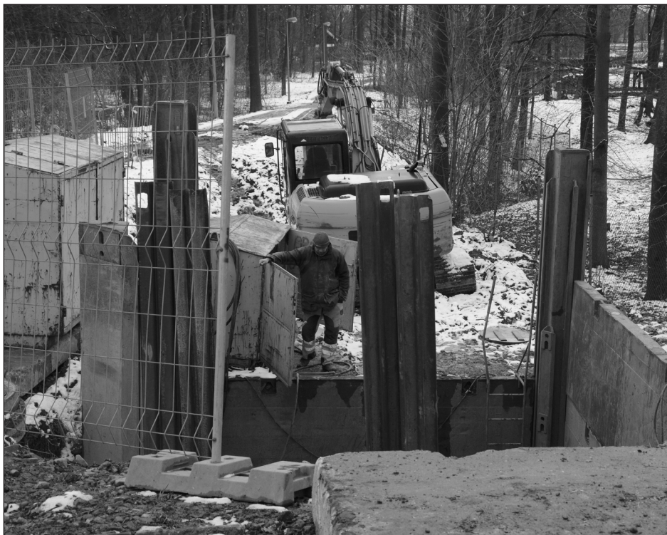
Práce na stavbě kanalizace v Mniši se doposud vyhýbaly komunikacím. To se ale brzy změní a řidiči se musí připravit na dopravní omezení. FOTO: DAVID MACHÁČEK
