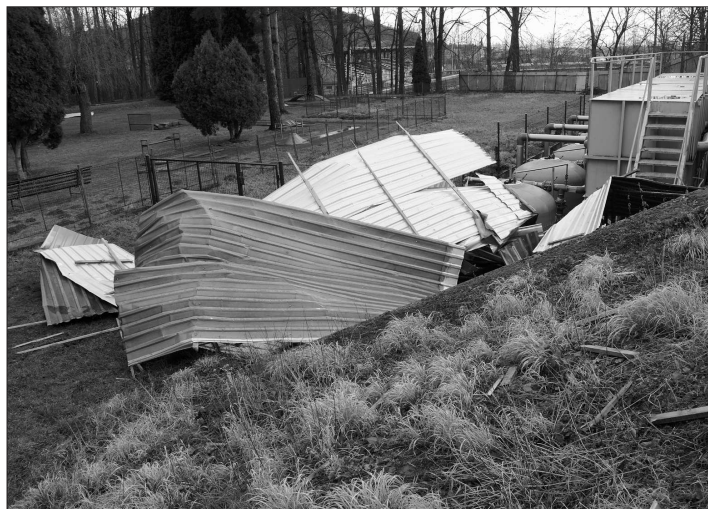
Plechová krytina z nedaleké restaurace skončila po řádění víchru nejen v prostorách koupaliště, ale i na sousedním minigolfovém hřišti.
