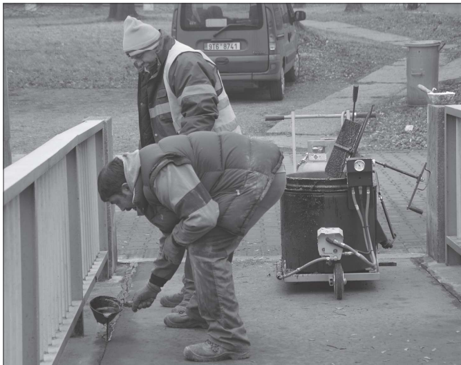
Pracovníci Slumeka opravovali pěť lávek přes Kopřivničku, některé z nich vyžadovaly rozsáhlejší opravy. FOTO: DANA HOĐÁKOVÁ
