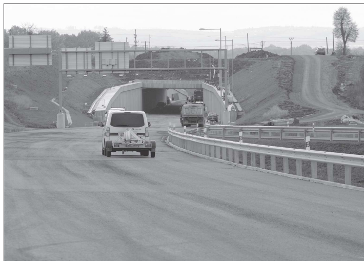
Obchvat Skotnice by měli stavbaři dokončit do Vánoc. Kdy po něm začnou jezdit řidiči, zatím Ředitelství silnic a dálnic není schopno odhadnout. FOTO: DAVID MACHÁČEK
