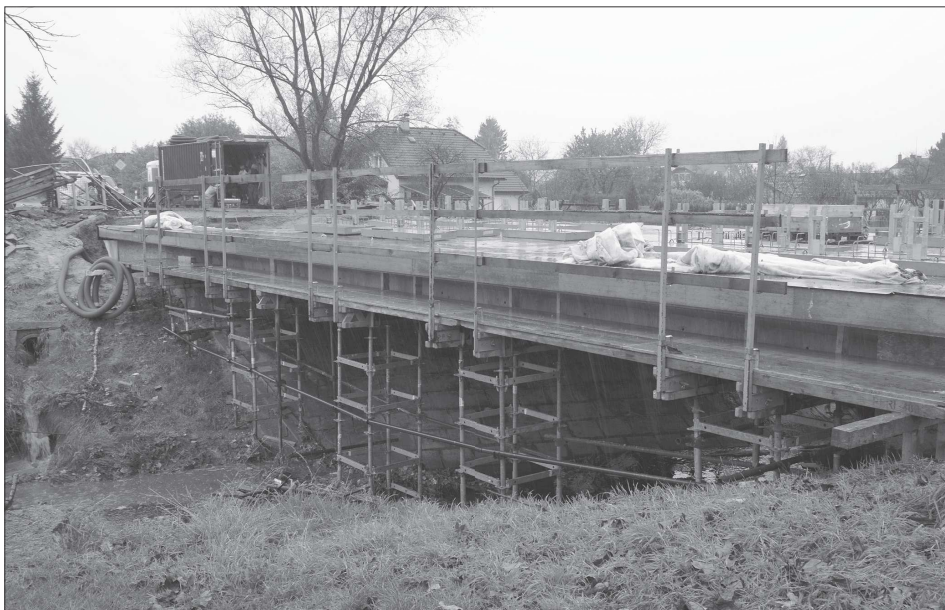
Špatné počasí i karanténa mezi pracovníky prováděcí firmy protáhne rekonstrukci mostu na ulici Severní zhruba o 14 dní. Dokončena by měla být do konce listopadu.
