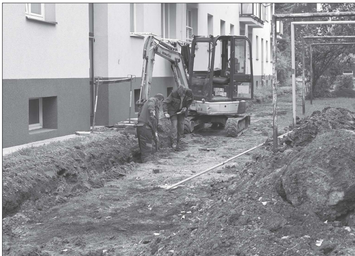
Pracovníci firmy Japstav Morava rekonstruují chodník za bytovým domem č. p. 874–6 na ulici Obránců míru. Nový chodník by měl být hotov do konce listopadu. FOTO: DANA HOĐÁKOVÁ
