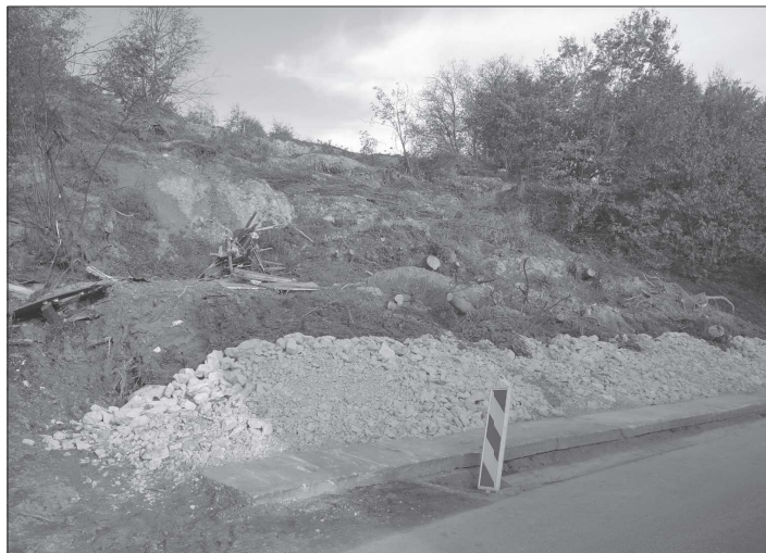
V minulém týdnu nechalo město odbagrovat zeminu ze sesutého svahu ve Větrkovicích, aby došlo k znovurozšíření komunikace. FOTO: DANA HOĐÁKOVÁ
