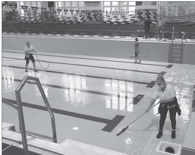
Z ekonomických důvodů došlo k vypuštění bazénové vany krytého bazénu v Kopřivnici. Čas do znovuvytvoření bude využit k dezinfekci a k realizaci dílčích oprav, které nelze provést za provozu.
