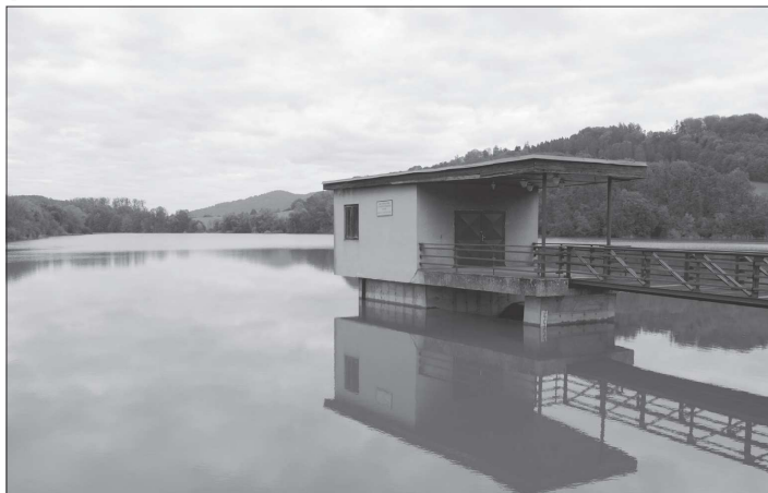
Během minulého týdne dosáhla hladina nádrže ve Větrkovcích svého maxima a poprvé od jara 2017 se voda dostala i za hranu bezpečnostního přelivu. FOTO: DAVID MACHÁČEK
