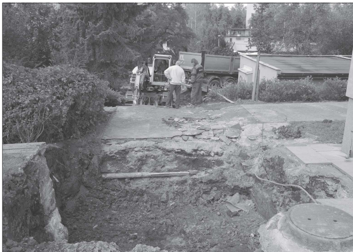
V minulém týdnu započala kompletní rekonstrukce schodiště na ulici Krátké. Původní bylo ve velmi špatném stavu. FOTO: DAVID MACHÁČEK
