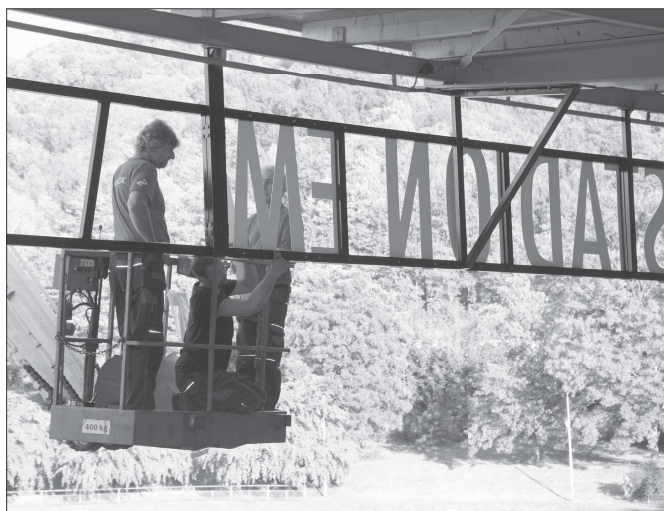
V polovině minulého týdne proběhla instalace nového nápisu na tribunu letního stadionu, ten už nyní viditelně nese jméno Emila Zátopky. FOTO: DAVID MACHÁČEK
