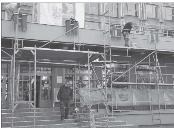
Hlavní vstup do budovy městského úřadu prošel renovací. Opravy přišly na necelých sto tisíc. FOTO: DAVID MACHÁČEK
