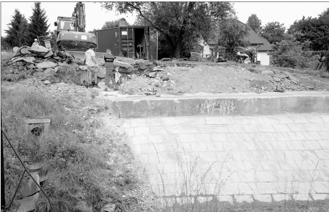
Původní most na ulici Severní v minulých týdnech prováděcí firma zdemolovala. Výstavba nového přemostění Kopřivničky by měla být dokončena do poloviny listopadu.
