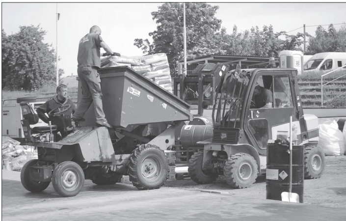
V minulém týdnu začala pokládka poslední vrstvy atletické dráhy na kopřivnickém letním stadionu, jehož rekonstrukce má být do konce června hotová.
