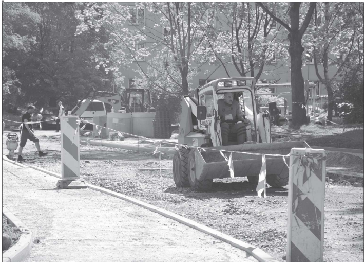
Stavba nových parkovacích míst na ulici Družební bude dražší. Projekt prodražily práce a dočasně, které nebyly součástí původního zadání.
