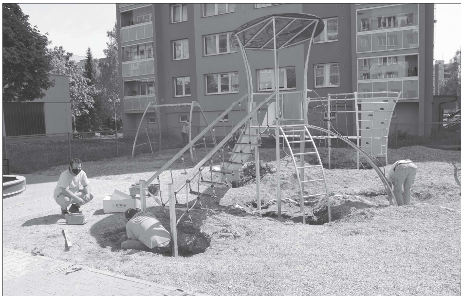
Vloni zrušené dětské hřiště na sídlišti Sever se dočkalo instalace nových herních prvků. Děti si nové prolézačky a houpačky vyzkoušejí už v tomto týdnu.
