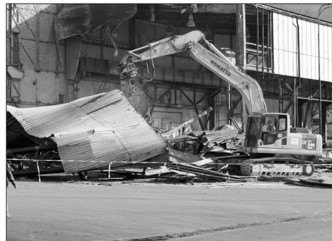
Demoličními pracemi v březnu začala proměna někdejší slévárny na muzeum nákladních automobilů.
