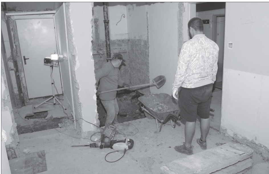
Rekonstrukce vnitřních prostor místního domu dětí a mládeže začala skoro o měsíc dříve. Po prázdninách DDM nabídne například FOTO: DAVID MACHÁČEK
