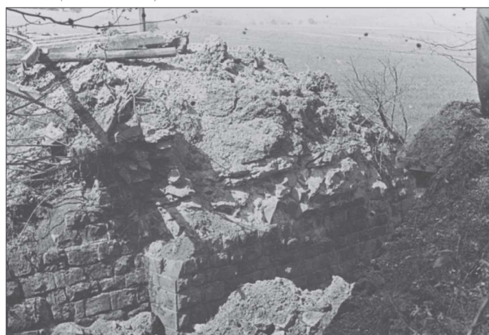
Viadukt na železnici mezi Štramberskem a Veřovicemi měla údajně zničit bomba, jejíž plášť byl další desítky let umístěn v parku E. Beneše.
