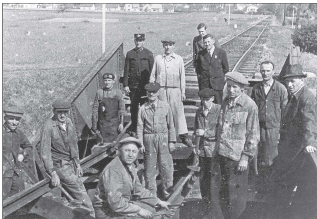
Při ústupu němečtí vojáci likvidovali dopravní infrastrukturu, ničili například most na trati mezi Příborem a Kopřivnicí, který následně opravovali zaměstnanci Tatry.
