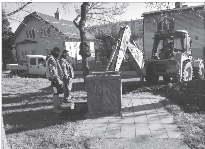
Minulý týden došlo k opravě vodovodní přípojky k pítku v parku na ulici Pionýrské. Oprava je součástí na letošní rok plánované revitalizace parku. FOTO: DAVID MACHÁČEK
