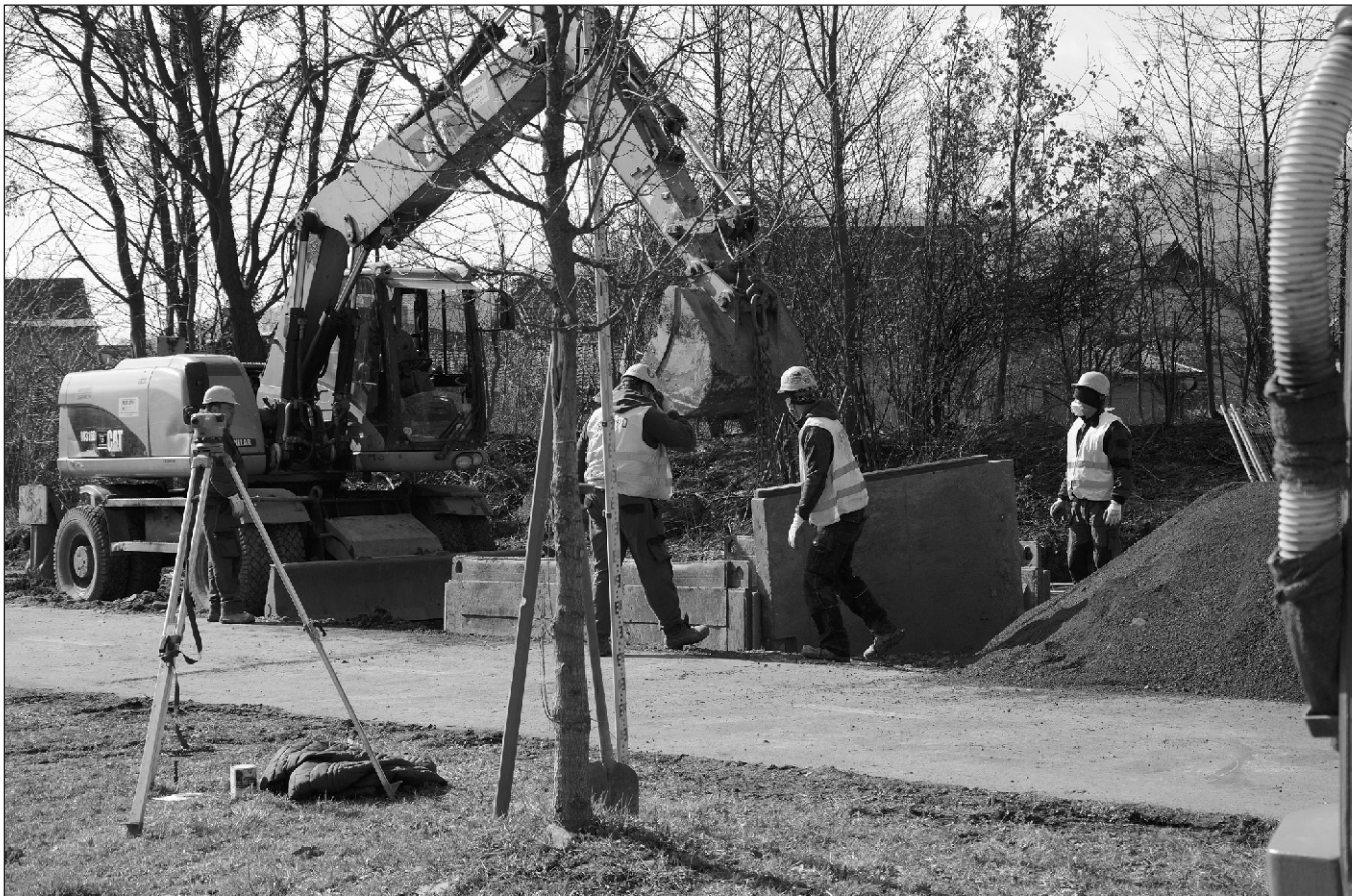
Prvního dubna začaly výkopové práce na první etapě stavby nové kanalizace ve Vlčovicích. Jako první začaly práce na stoce A vedoucí kolem cyklostezky z Lubiny do Vlčovic. FOTO: DAVID MACHÁČEK
