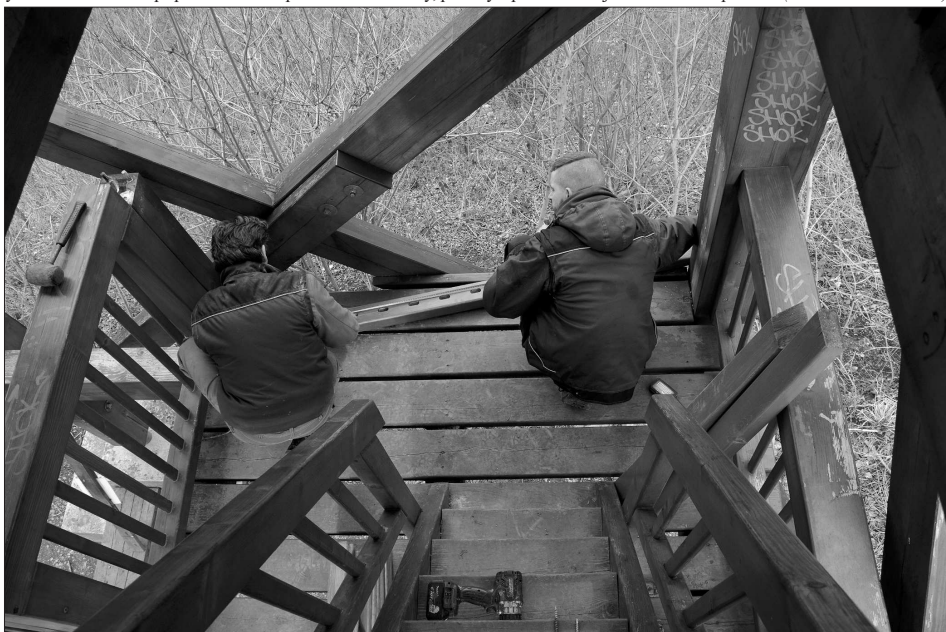
Na začátku tohoto týdne proběhla na Bezručově vyhlídce výměna poškozených částí dřevěné konstrukce. Po opravách je věž znovu přístupná veřejnosti. FOTO: DAVID MACHÁČEK
