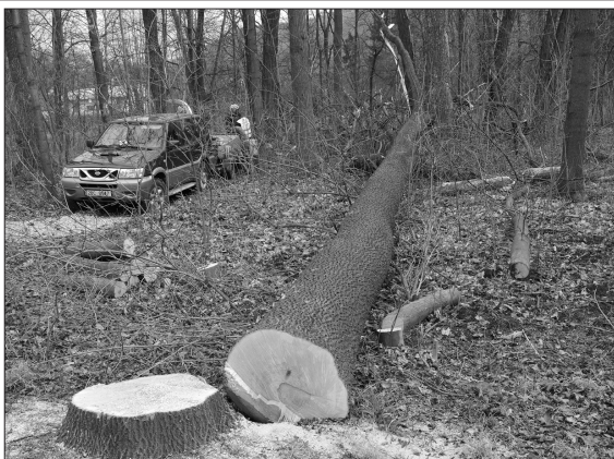
Kácení stromů na trase budoucí kanalizace začaly práce na odkanalizování místních částí Vlčovic a Mniší. FOTO: DAVID MACHÁČEK
