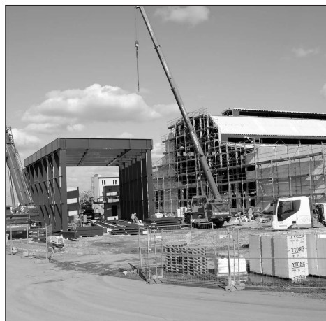
Stavba nového muzea a depozitáře pro Slovenskou strelu je v plném proudu. Součástí Akčního plánu pro letošní rok je vybudování přístupových cest, úprava předprostoru a vybudování provizorního parkování.
