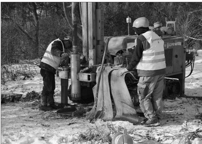
V tomto týdnu specializovaná firma ukončí vrtné práce v areálu bývalé skládky za zdejší čistícího odpadních vod. Odebrané vzorky nyní poputují do laboratoří. FOTO: DAVID MACHÁČEK
