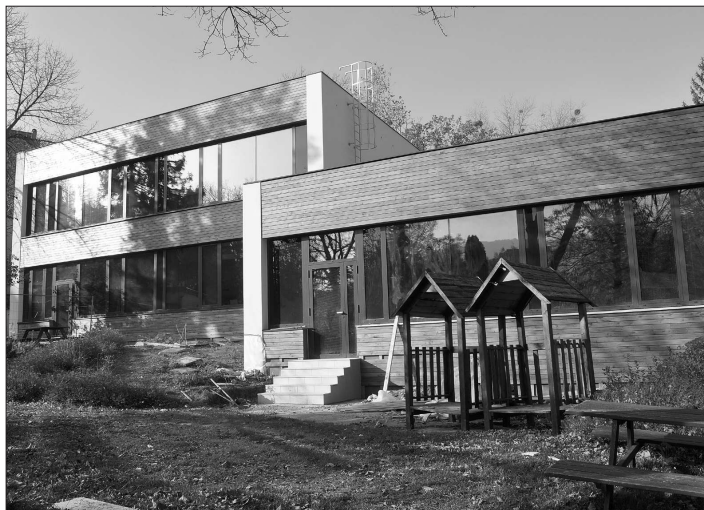
Rekonstrukce budovy Mateřské školy I. Šustaly byla dokončena. Úpravy okolí budou ale provedeny až na jaře příštího roku.
