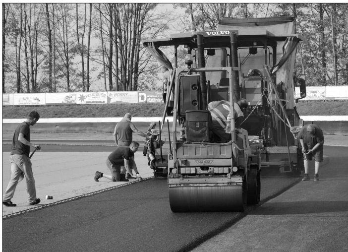
Pro letošní rok se práce na rekonstrukci letního stadionu chýlí ke konci. Stavební firma položila asfaltové povrchy pod budoucími tartanovými drahami. FOTO: DAVID MACHÁČEK
