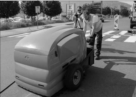
Zařízení, které mohli Kopřivničané v minulých týdnech vidět v ulicích, skrývá mikrovlnnou technologii pro opravu děr na silnicích. FOTO: DAVID MACHÁČEK
