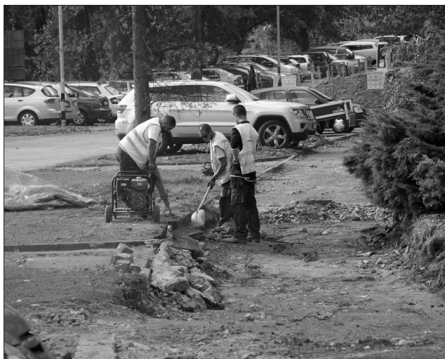
Na ulici I. Šustaly probíhá rekonstrukce plynového potrubí. Na ni naváže celoplošná předložba chodníků dotčených stavbou.
