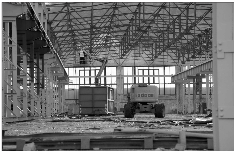
Pracovníci stavební firmy ošetřují skelet někdejší slévárenské haly, která se má proměnit v nové muzeum automobilů. V těchto dnech v sousedství začne i stavba nového depozitáře pro Slovenskou strelu. FOTO: DAVID MACHÁČEK
