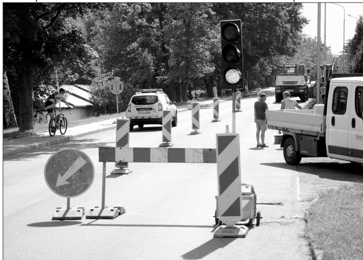
Po dobu výstavby nového chodníku u rodinné zástavby naproti Alšově ulici se musí řidiči řídit na dopravní omezení. FOTO: DAVID MACHÁČEK
