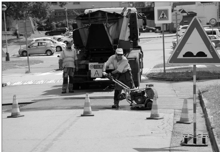
Zatímco výtluky jsou opravovány postupně, celoplošné opravy povrchů tří místních komunikací proběhnou na přelomu září a října.
