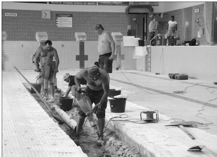
Odstranit zrezivělé potrubí cirkulace vody na krytém bazénu v Kopřivnici nešlo jinak než za použití hrubé síly pneumatických bouracích kladiv. FOTO: DAVID MACHÁČEK
