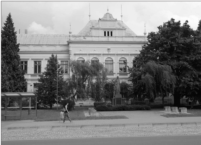
Stav střechy bývalé ZŠ Náměstí není dobrý. Do budovy zatím není možné vstoupit. Do budovy zatím není možné vstoupit. Do budovy zatím není možné vstoupit. FOTO: DAVID MACHÁČEK
